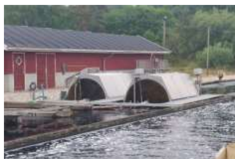
Pisciculture Lofstrup Tambours pour filtration de l'eau
